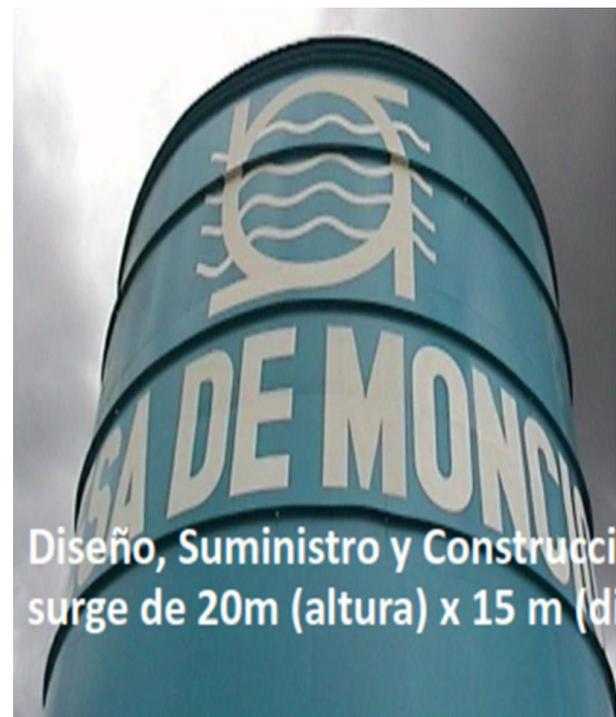
Diseño, Suministro y Construcción de tanque de metal a la surge de 20m (altura) x 15 m (diámetro).
