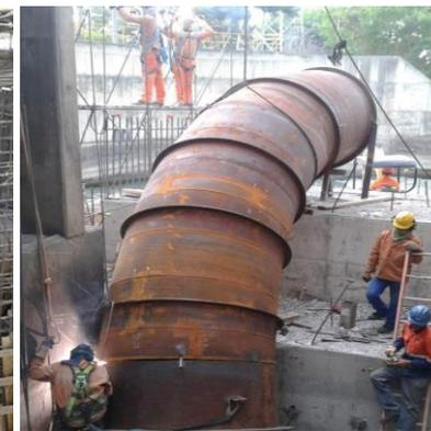
Diseño, fabricación y montaje de conducto forzado y cono dissipador para reubicación de válvula chorro hueco DN 1,700 mm.
