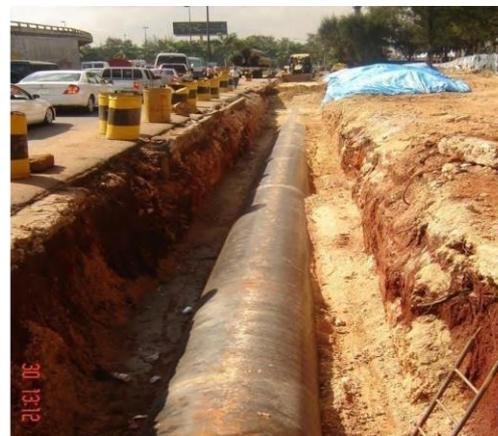
Instalación de conducto, interconexiones y accesorios de 36", 48" y 54" de diámetro.
