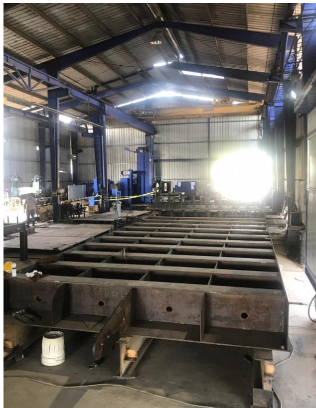
Compuerta Desalizante - Fábrica
