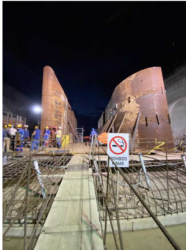
Montaje del Blindaje
