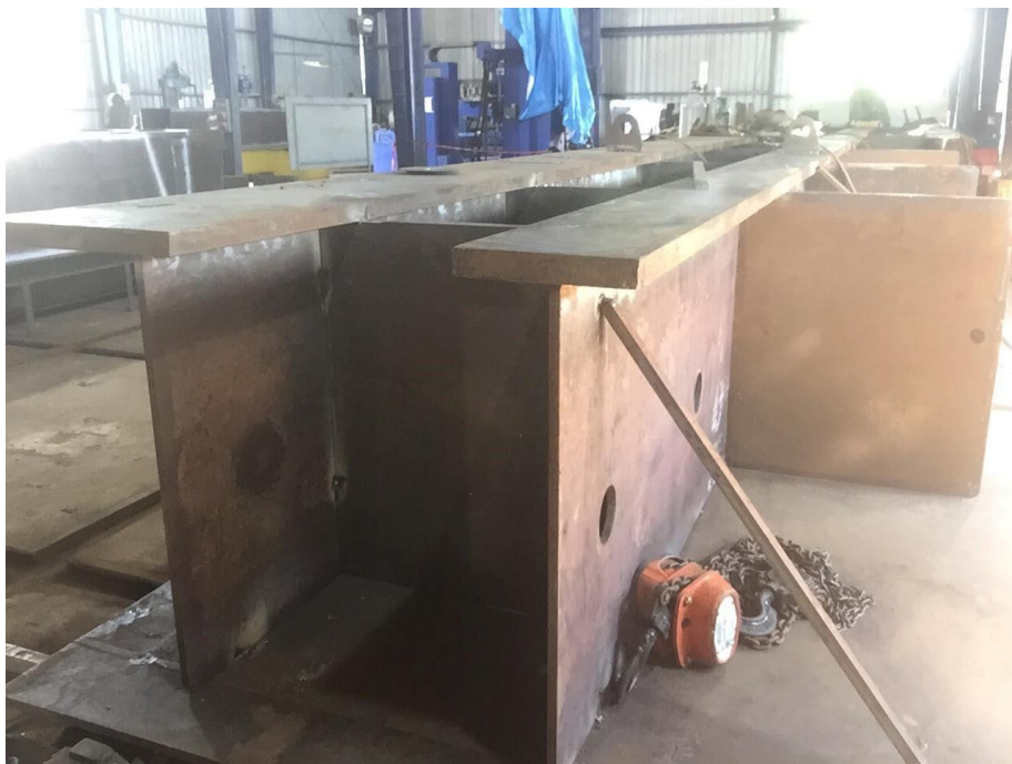
Compuerta Vagón (fabricación)
