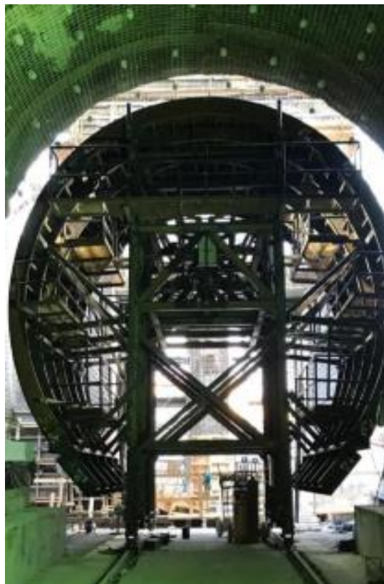
Encofrado metálico Túneles Desvío del Río
