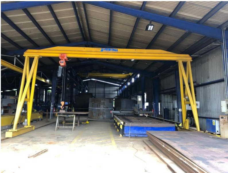
Pórtico grúa 5ton
