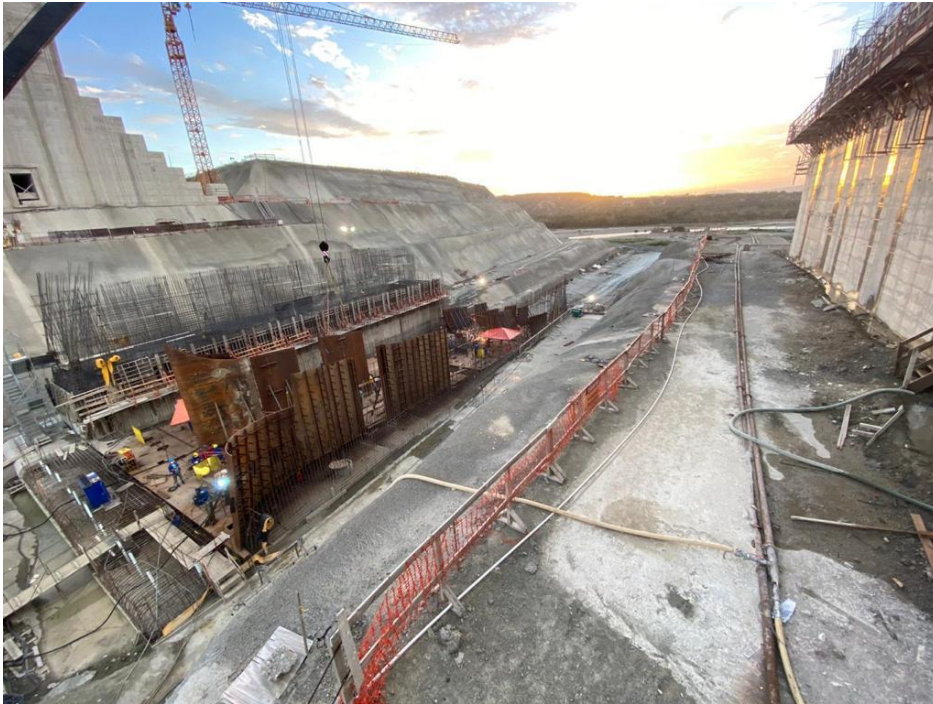
Montaje del Blindaje
